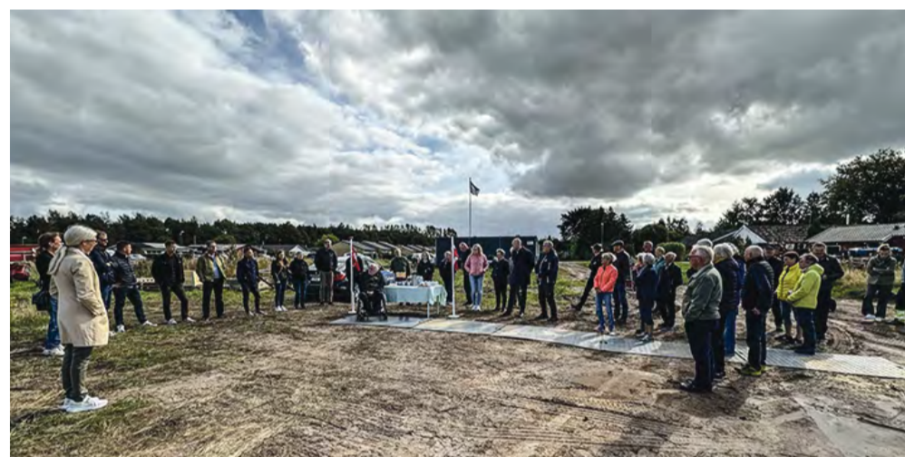
Der var fin opbakning til 1. spadestik på den nye boligbyggeri på Gråspurvej i Thyregod. Foto: Jean Darly
