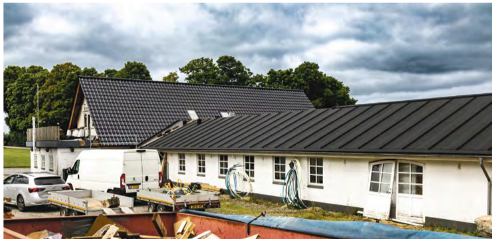
Kjeld Tofte Tofte Thisgaard, der har virksomheden KTT Tofte Holding ApS, har igangsat renoveringen af bygningerne, der tidligere husede den legendariske landsbykro, som bliver til 6 lejligheder. Foto: Jim Hoff
